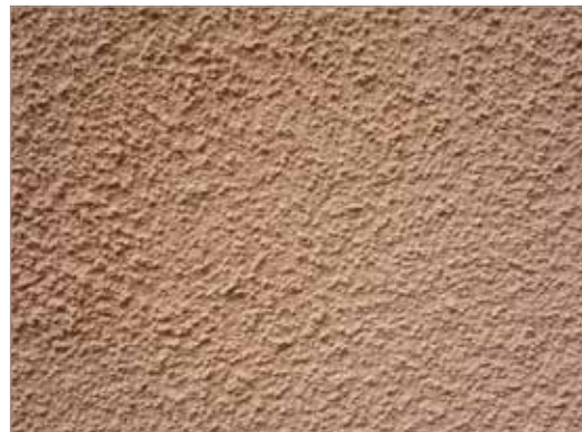
Abb. 43 Außenputz – geriebene Struktur
