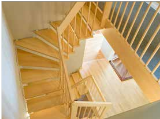
Abb. 18 Holmtreppe; massiv Buche
