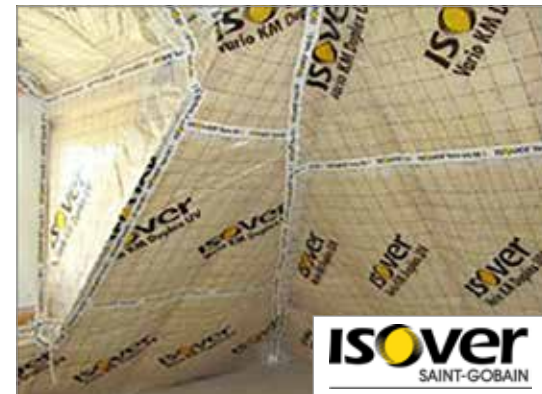
Abb. 52 Dämmung mit Dampfsperffolie
