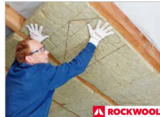
Abb. 51 Mineralwolle-Dämmung
