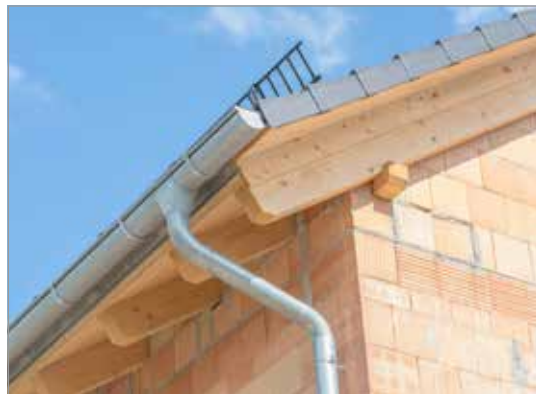
Abb. 16 Dachrinne und Ablauf
