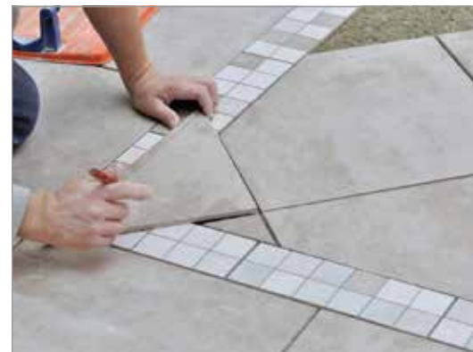
Abb. 38 Bodenfliesen mit Bordüre etc.
