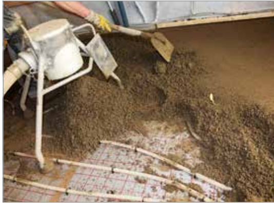
Abb. 35 Estrichtleger bei der Arbeit
