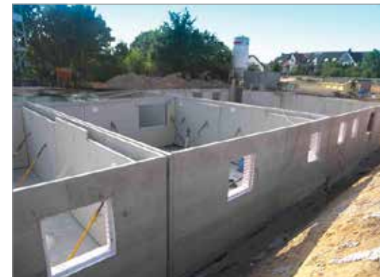
Abb. 06 Kellerfenstersituation außen
