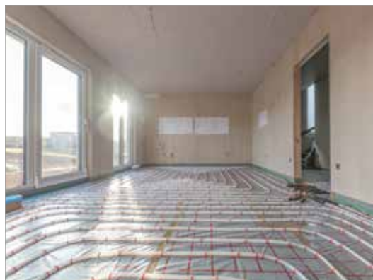
Abb.25 Fußbodenheizung
