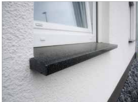
Abb. 54 Außenfensterbank aus Granit
